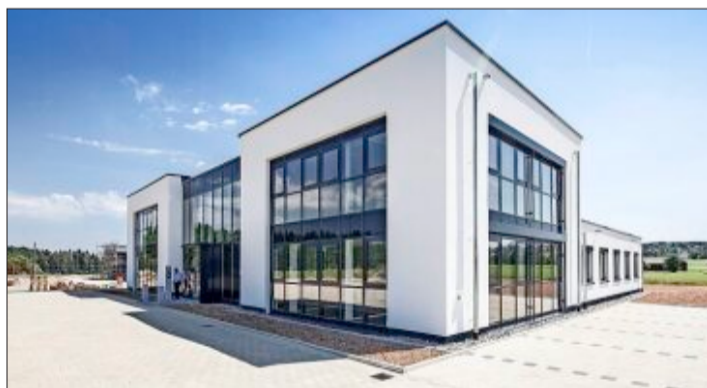
Der Neubau der Firma Bauknecht in Schramberg wurde von Industriebau Schauenberg realisiert und schlüsselfertig übergeben. Foto: zVg
